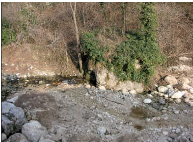
Fig. 2 - Il torrente dopo i lavori di sistemazione idraulica, gennaio 2007 (foto P. Bellora).
