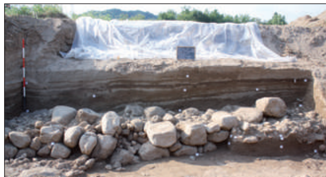
Fig. 12 - Muratura in blocchi di basalto sulla destra idrografica dell'attuale corso dell'Agno, corrispondente ad un'opera di strutturazione della sponda di epoca contemporanea (foto PETRA soc. coop., archivio SAR-VEN).
