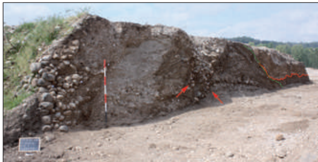
Fig. 9 - Sezione trasversale al corpo dell'argine veneziano. In primo piano, l'ultimo paramento interno in ciottoli basaltici; le frecce rosse indicano i due paramenti precedenti, danneggiati dalla furia delle acque; in secondo piano, la linea verde tratteggiata mostra il profilo del paramento esterno, quella rossa i livelli di tracimazione, in appoggio all'argine, su cui si imposta il sistema a "vasche" (foto PETRA soc. coop., archivio SAR-VEN).
