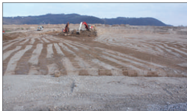
Fig. 14 - Scavi in corso nell'ambito del sistema 1 (foto PETRA soc. coop., archivio SAR-VEN).
