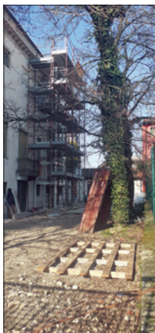
Fig. 5 - Lavori in corso per l'installazione dell'ascensore.
